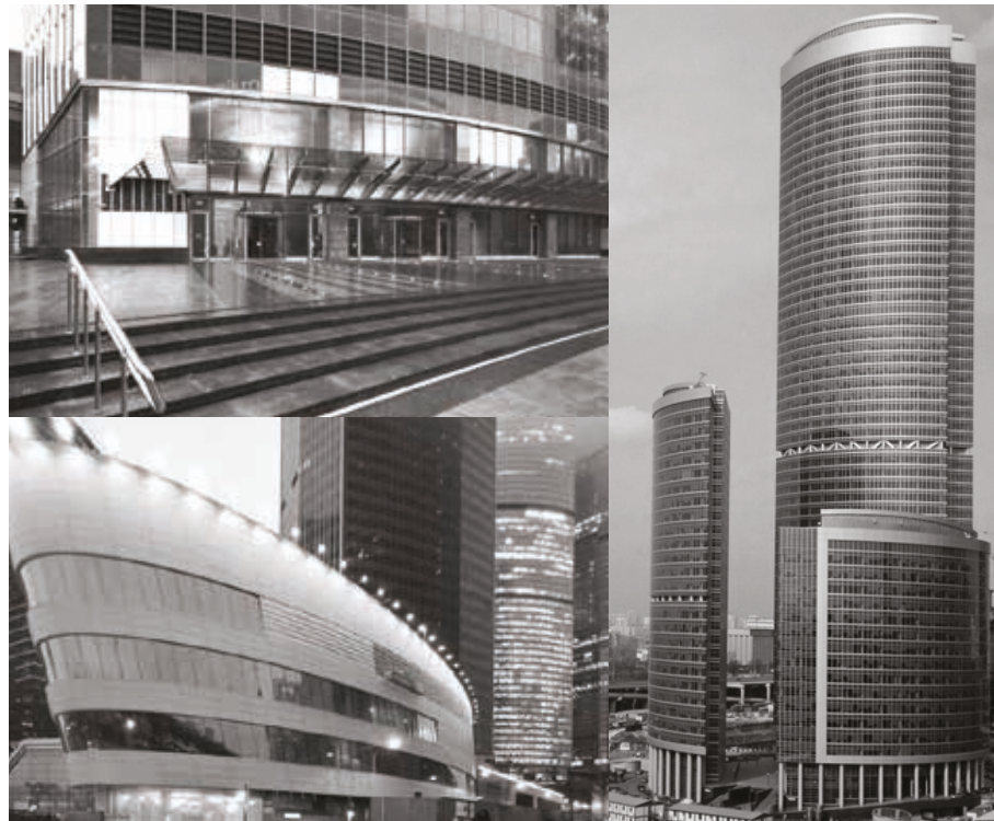
Башня «Евразия» г. Москва, ММДЦ «Москва-Сити»
