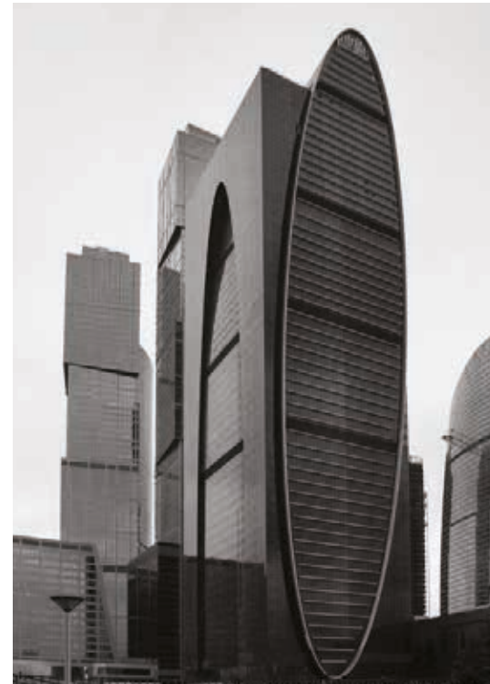
Башня «Imperia Tower» г. Москва, ММДЦ «Москва-Сити»
